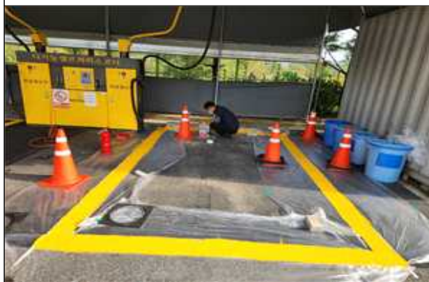
개선 작업 중
